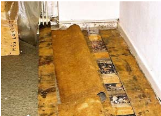
Abb. 2.1.1.4.1-5 Von oben nur teilweise geöffnete Holzbalken-Kellerdecken, in die Einblasdämmung eingebaut werden soll
