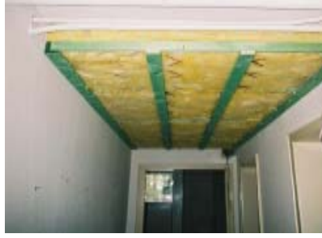
Abb. 2.1.1.4.3-7 Unterseitige Dämmung einer Beton-Kellerdecke in Leichtbauweise
