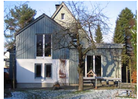
Südfassade nach Sanierung mit vergrößerten Südfenstern
