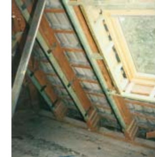
Schrägdachdämmung von innen mit innerer Sparrenaufdoppelung
