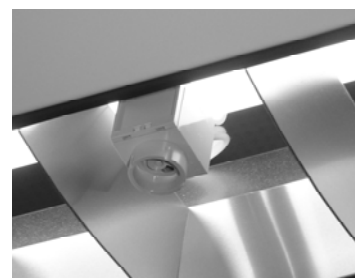
Helligkeitssensor in einer Büroleuchte
