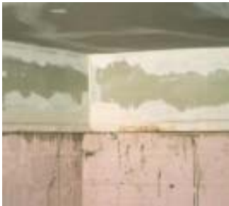
Abb. 2.1.1.4.3-8 Unterseitige Dämmung einer Beton-Kellerdecke mit PS-Hartschaumplatten
