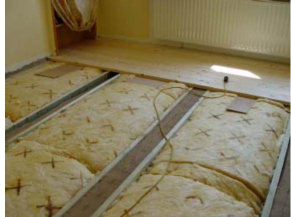
Abb. 2.1.1.4.1-4 Von oben ganz geöffnete Holzbalken-Kellerdecke mit neuer Dämmfüllung
