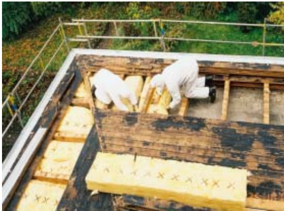
Holz-Kaltdachsanierungen von oben
