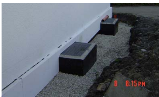
Abb. 2.1.1.2-3 Außendämmung der Keller-Außenwände im Sockel- bereich anlässlich der Sanierung der Wasserabdichtung
