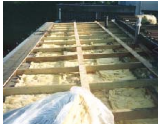
Holz-Kaltdachsanierungen von oben
