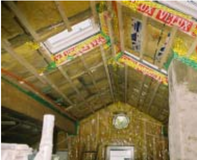
Schrägdachdämmung von innen mit innerer Aufdoppelung und neuen luftdichtenden Folien
