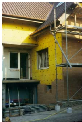
Abb. 2.1.2.2-3 Kerndämmung und Klinker vor ehemaliger Putzfassade Wandstärke dann 56 cm
