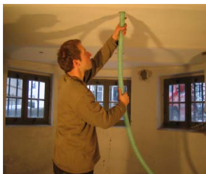
Abb. 2.1.1.4.2-3 Stahlträger-Kappendecke Einblasen von Dämmstoff von unten durch angebohrte Kappen
