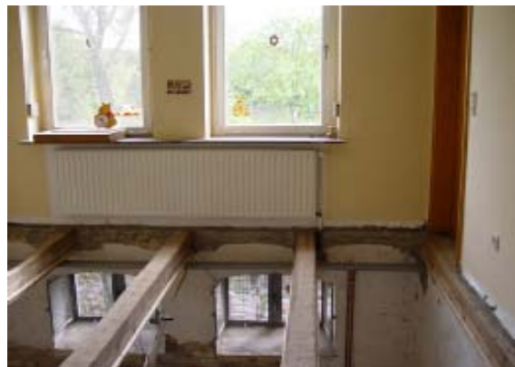
Abb. 2.1.1.4.1-6 Von beiden Seiten wg. nötiger Balkensanierung geöffnete Holzbalken-Kellerdecke
