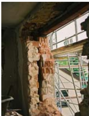
Abb. 2.1.2.3-5 Fensteranschnitt noch ohne Randabdichtung
