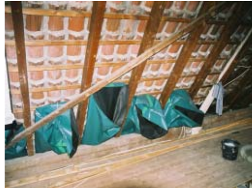
Abb. 2.1.4.1-6 Varianten der Dämmung nur im Sparrenzwischenraum ohne Bauteilöffnung mit Perlite Schüttdämmstoff (links) und Zellulose in Säcken (rechts)
