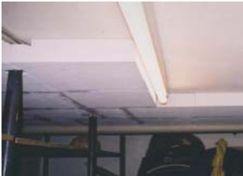
Abb. 2.1.1.4.3-8 Unterseitige Dämmung einer Beton-Kellerdecke mit PS-Hartschaumplatten
