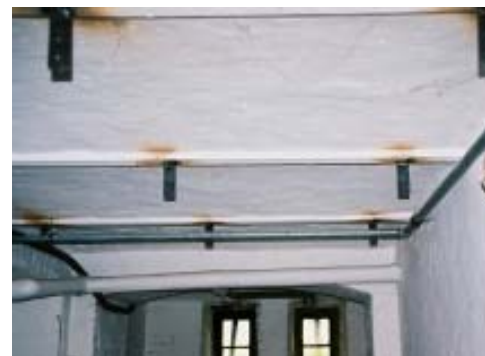
Abb. 2.1.1.4.2-4 Stahlträger-Kappendecke mit unterseitig angeschweißten Haltetaschen für die Traglatten einer unterseitigen Dämmkonstruktion
