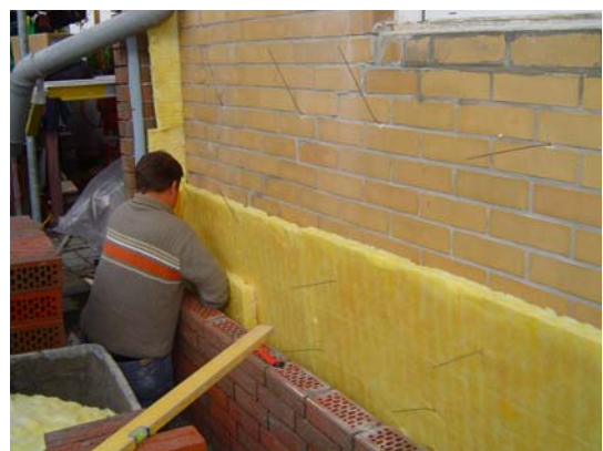
Abb. 2.1.2.2-4 Zweilagige Kerndämmung und neue Verklinkerung über den alten Klinker hinweg. Wandstärke nachher 64 cm (24+3+11,5+14+11,5)
