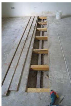
Abb. 2.1.1.4.2-2 Stahlträger-Kappendecken oberseitig teilgeöffnet für Einblasdämmung
