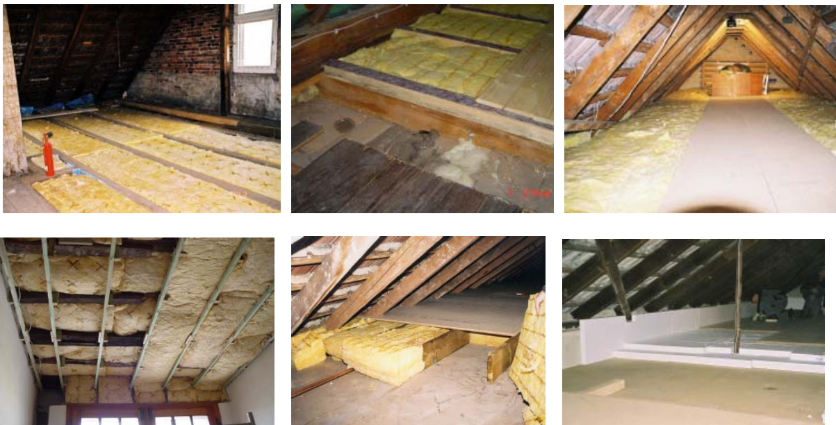
Ab. 2.1.4.2-7 Dämmung von Kehlbalkendecken - Ausführungsvarianten
