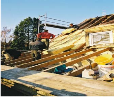
Schrägdachdämmung von außen Dämmung zwischen und auf den Sparren
