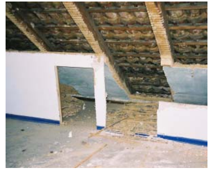
Schrägdach von innen geöffnet bisher ohne Dämmung hinter der Innenbekleidung
