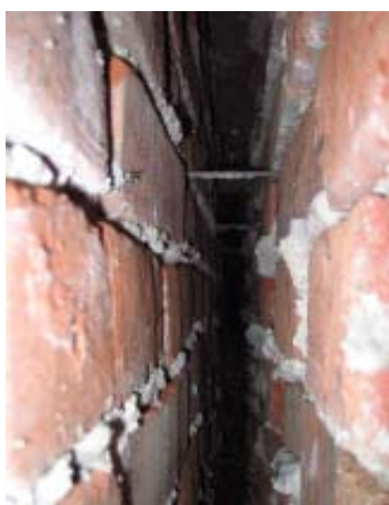
Abb. 2.1.2.3-4 Luftschichtmauerwerk Einblick in den 8 cm breiten Luftspalt
