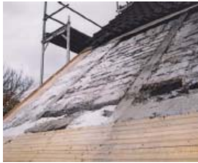
Schrägdach mit Leichtsteinfüllung
