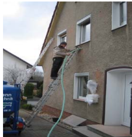
Abb. 2.1.2.3-6 Luftschichtmauerwerk Einblasen des Dämmstoffs
