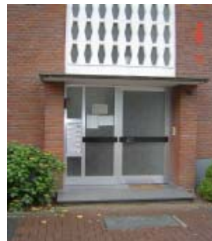
Typische alte Aluminiumtür aus nicht getrenntem Profil U_D -Wert um 6 \text{ W/m}^2\text{K}
