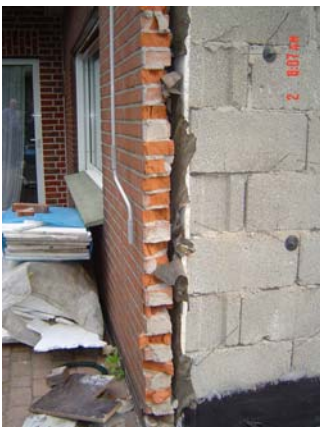
Abb. 2.1.2.2-2 Abbruch des Klinkers zwecks Dämmung mit WDVS direkt auf Hintermauer. Wandstärke 39 cm
