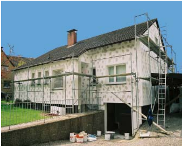
Abb. 2.1.2-4 Typische Außendämmung eines Hauses mit einschaligem Mauerwerk
