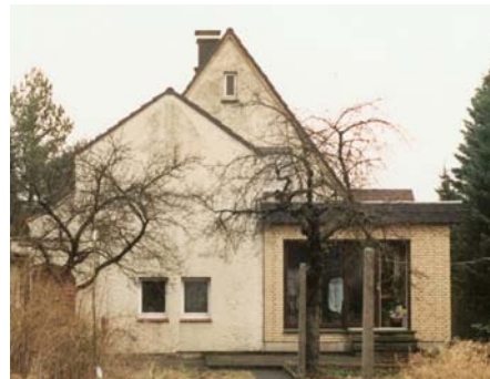
Südfassade vor der Sanierung mit nur wenig Südfenstern
