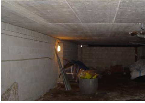
Abb. 2.1.1.4.3-6 Betondecke über Kriechkeller vor der Dämmung
