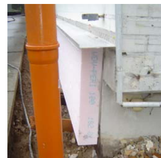
Abb. 2.1.1.2-4 Außendämmung nur des luftberührten Sockelbereichs als Mindestdämmung der Oberkante der Kellermauer
