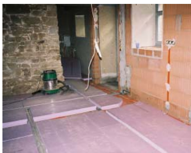
Abb. 2.1.1.1-2 Nachträgliche oberseitige Dämmung einer vorher ungedämmten Keller-Sohlplatte mit 12 cm Dämmstärke.
