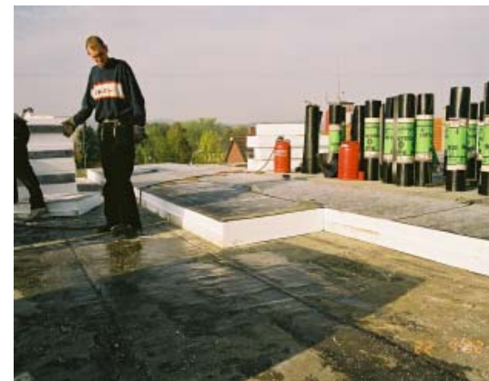
Beton-Fachdachsanierung von oben (24 cm)
