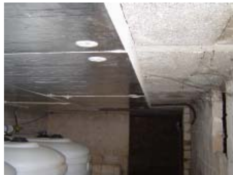
Abb. 2.1.1.4.3-9 Unterseitige Dämmung einer Beton-Kellerdecke mit PU-Hartschaumplatten
