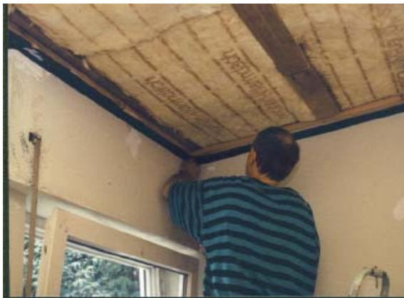
Holz-Kaltdachsanierung von unten
